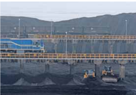
貯炭場。貨車の底が開口して石炭は落下する
