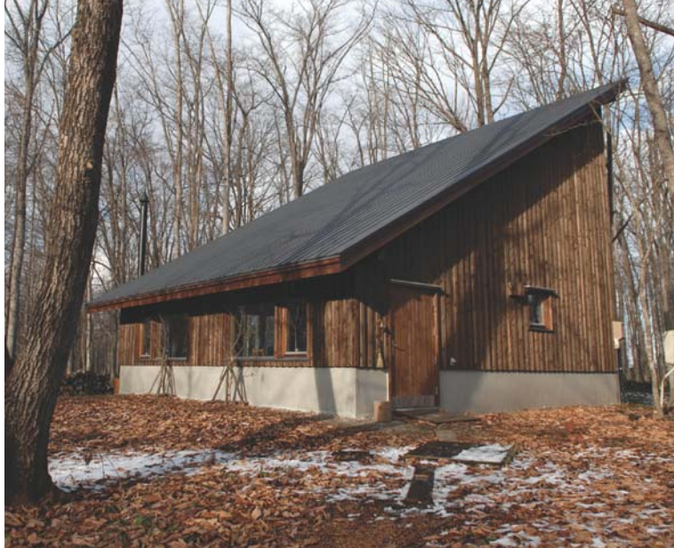
建築家が設計した金澤家。道産カラマツを主材にしている
