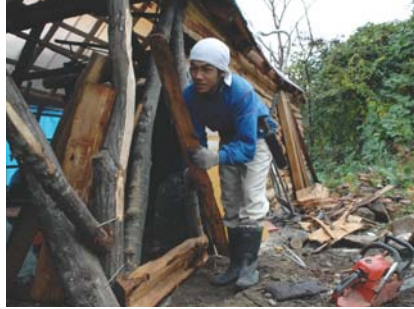
念願の炭焼き 窯は完成したが小屋の 雪囲いはまだ。作業する柳沢悟さん
