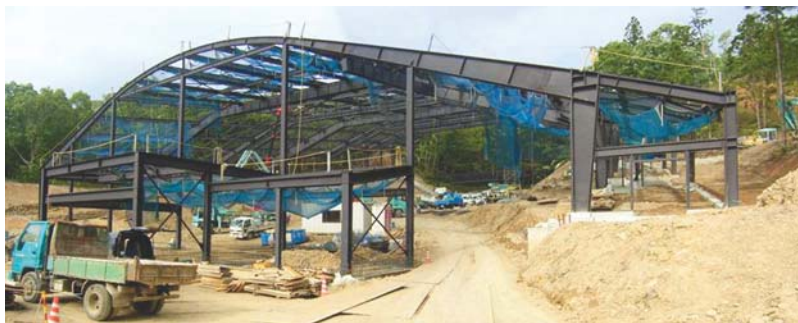
▲建設中の野生順化ゲージ
