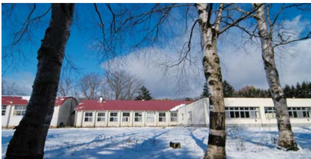
いまは空室で倉庫になっている湯里小学校の別棟
