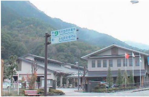
上松技術専門校の校舎、実習棟
