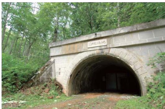
▲元山第二通洞入口 ▼倶知安内第一通洞入口
