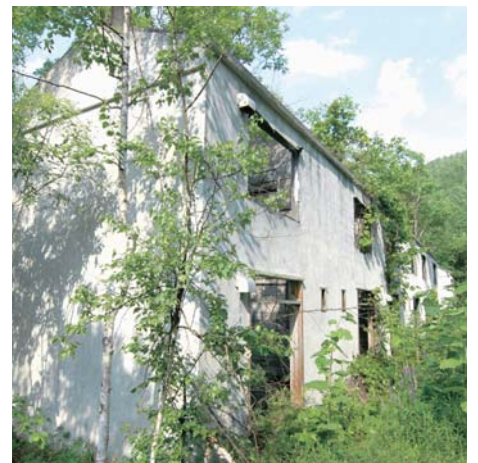
▲道路脇に残っている集合住宅
