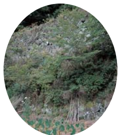
高さ12mある日本一の 石垣・日之影町戸川
