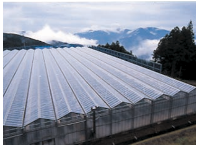
強力な鉄骨造り・70aのトマトハウス
