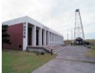
石油記念館/我が国の機械による石油掘削の1号井跡を近代石油産業発祥の地として記念館を建立、参考品を陳列している。またここは世界初の海底油田掘削地でもある。
