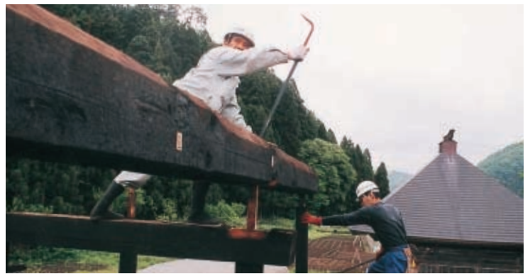
屋根の基底部である桁を外す
