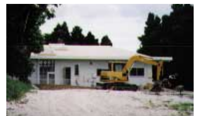
P建設中の町営住宅2軒。応募資格は
