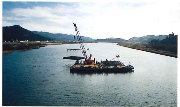
粗朶木マットを川床へ据付ける
