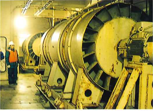
▲波を風に変え、タービンが回って電力に
