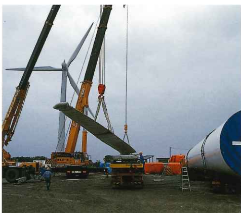
▲工事中のドリームアップ苫前現場。1基の出力は1500～1650kWという大型機で、羽根の長さは33m、これを地上60mのところへ設置するという大変な作業だ。
