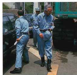
▲工事現場を視察する堀達也道知事
