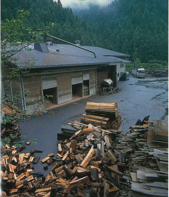
粉炭センター外観(上)と工場内部、炭化炉。
