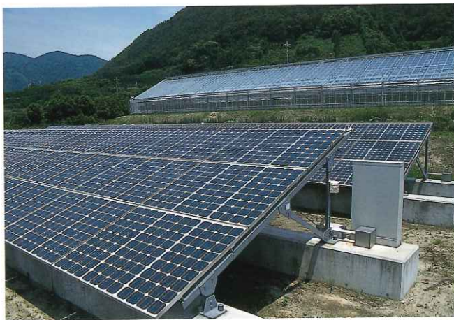
■太陽電池・モジュール/単結晶シリコン125mm角セル36枚 最大出力85.5W アレイ/モジュール234枚・総最大出力20.007kW
