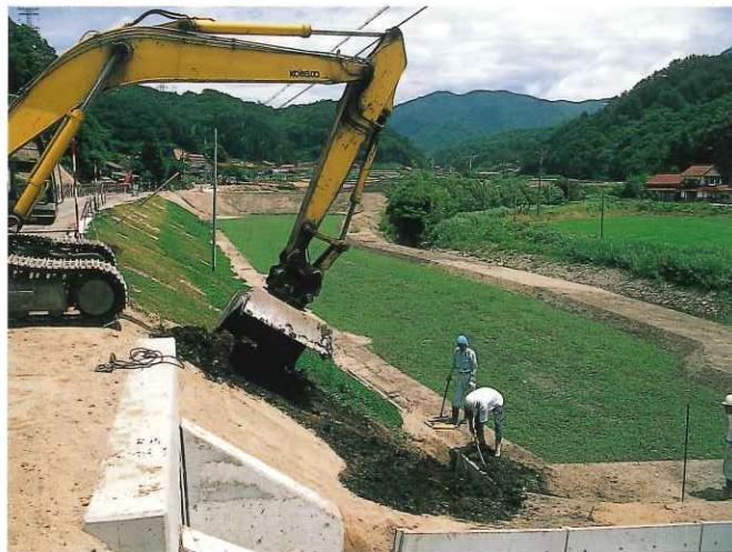
最後のほ場整備工事が行われている。
