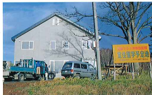
▲定住留学予定地に建設中のモダンな家。
