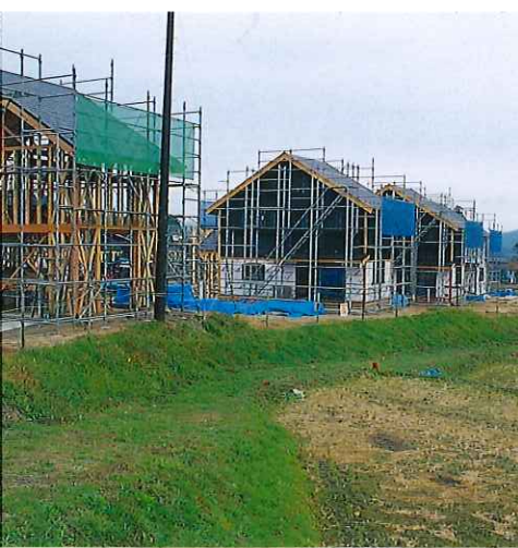
建設中の滞在型市民農園。
