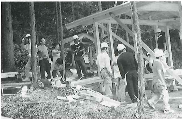
家を建てるための基礎作業。
