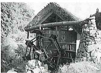
麓川にかかると水車小屋
