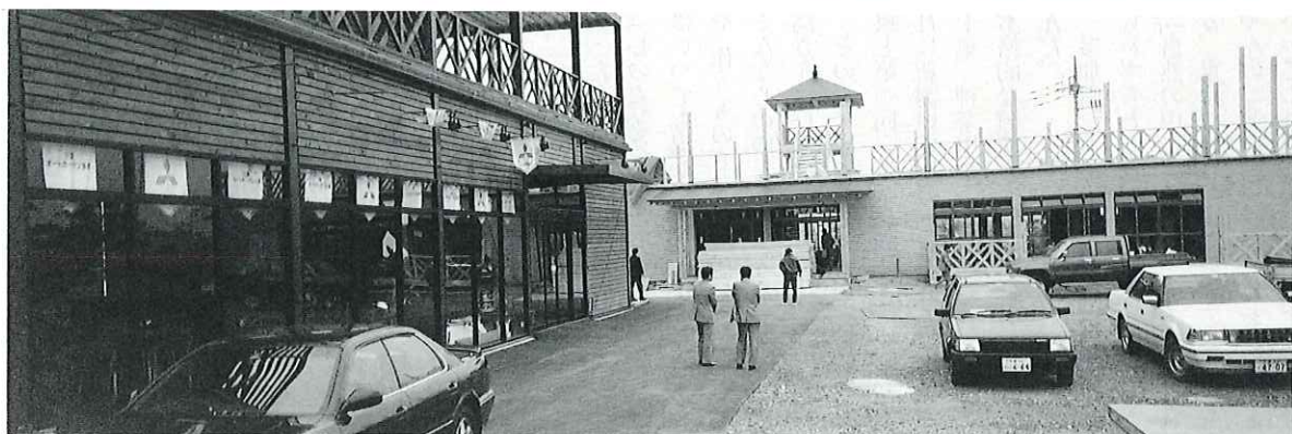
「ハーベスト・ワーフ」の建物。右が建築中の日棟。
