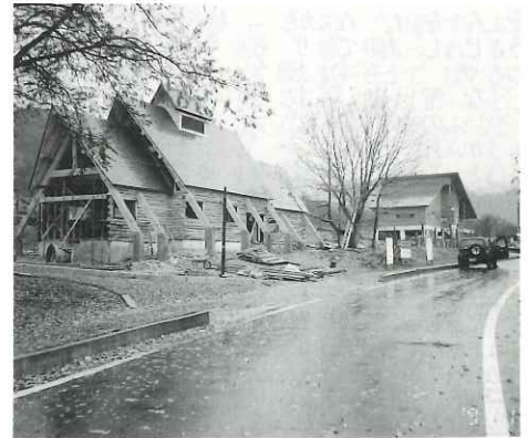
町内で建築中のログハウス
