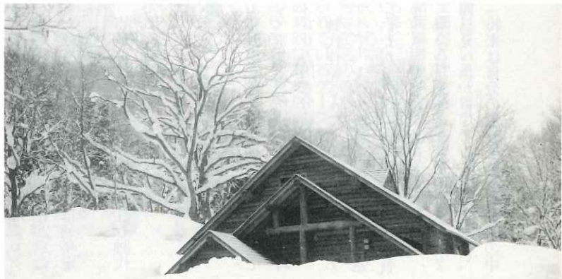
冬には屋根のところまで雪が積もる
