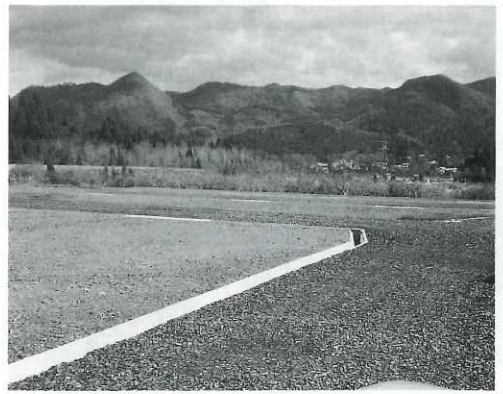
陣場岱地区造成地
