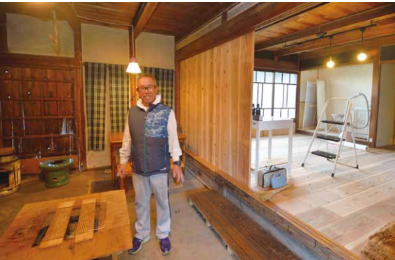
▲湯浅さんが改装した厨房と整体ルーム
