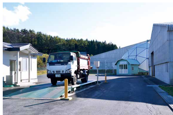
▼原料がセンターに搬入されると、トラックスケールで車両ごと計量
