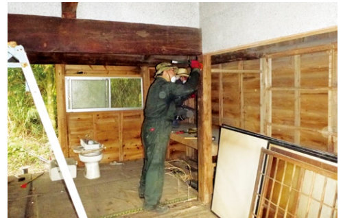
▲住民たちの手で空き家を改修、リフォーム
