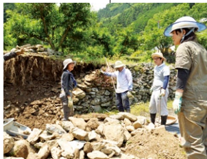
▲徳島県吉野川市美郷／ 崩れそうな石垣の再生「石積み学校」
