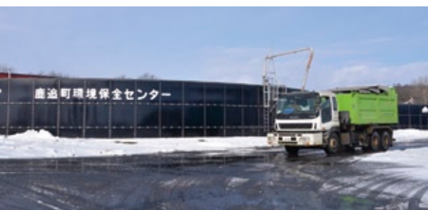
▲鹿追町環境保全センター入口にある消化液貯留槽。ふん尿を積んだコンテナが帰ってきた
