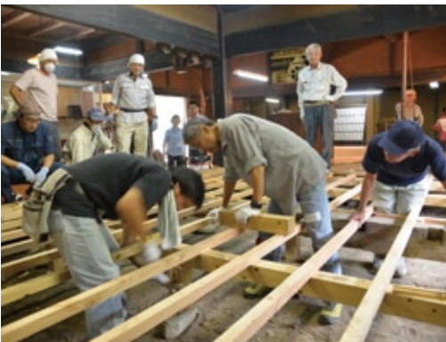
▲郷土館の床をはがすと太い支え木が現れた。さらに支柱を支える石を並べて新たに床板を張っていく ▲水平に支柱を張ったあとは、杉板の床を寸分の狂いなく敷いていく
