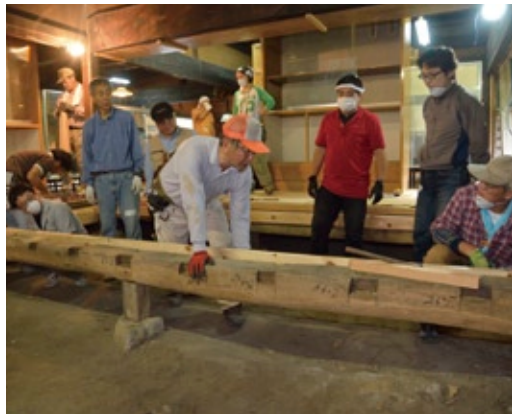
▲郷土館の床をはがすと太い支え木が現れた。さらに支柱を支える石を並べて新たに床板を張っていく ▲水平に支柱を張ったあとは、杉板の床を寸分の狂いなく敷いていく
