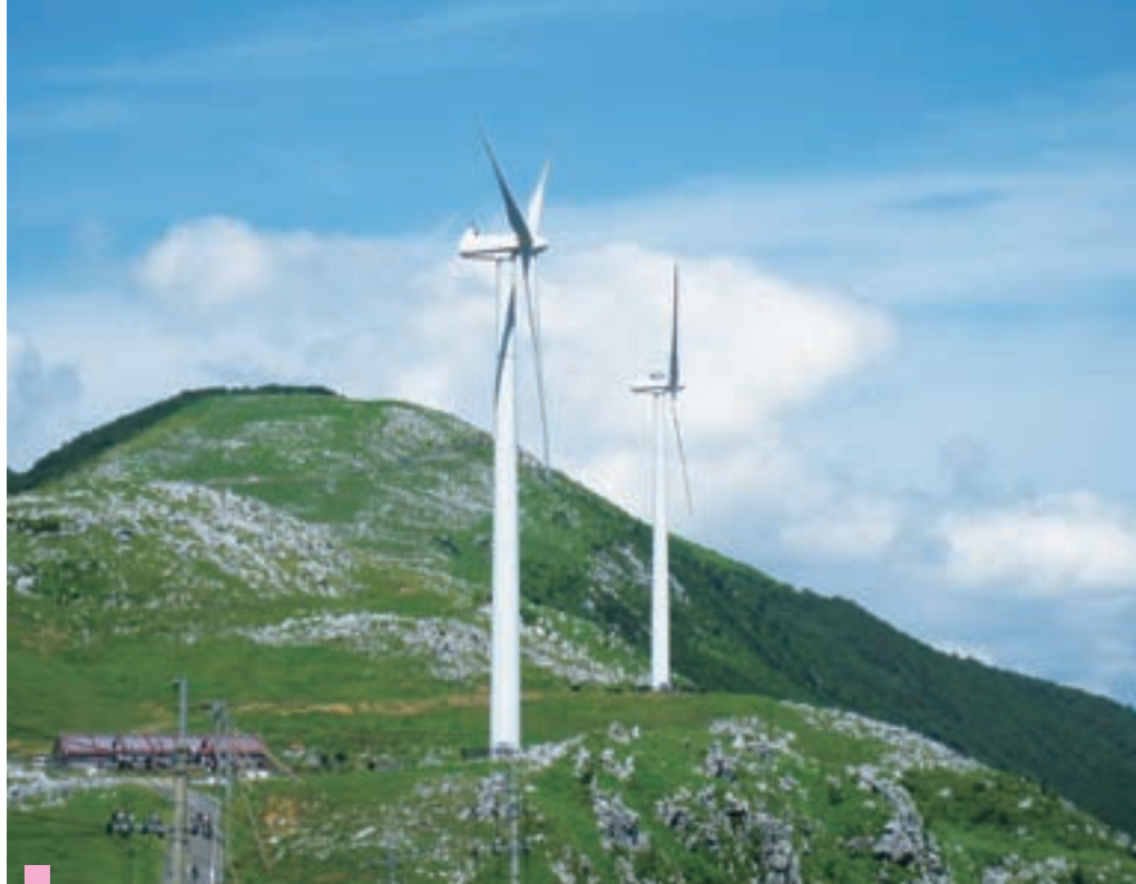
▲四国カルストに設置された風力発電所。風車はデンマーク製で出力600kWが2基。年間平均約2,900MWhの電力を生み出す
