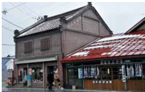
▲上／明治38年、喜多方市内で、最初に建てられた若喜商店煉瓦蔵。下／ハイカラな蔵の壁面の「金田洋品店」の切文字。100年の時を刻む
