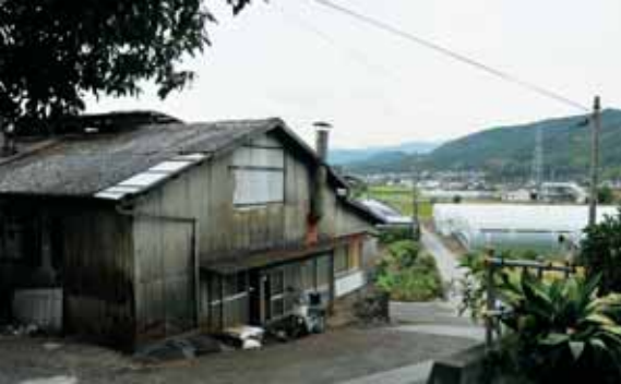
宗石工房の建物。石垣を設置し、左手に長い
