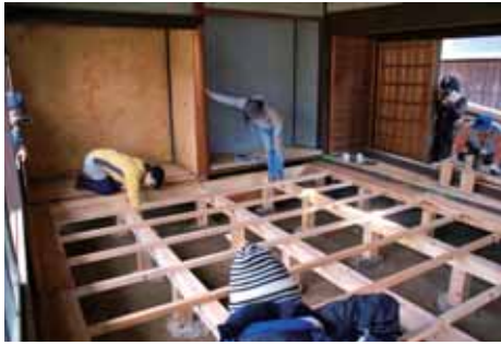
▲床板を張る床組の部材(束、大引、根太)
