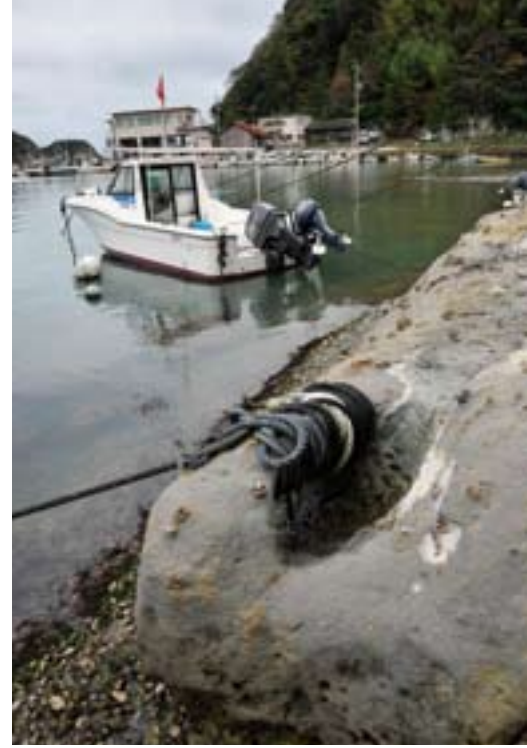
▲温泉津港の岩場に多数残る「鼻ぐり岩」。船を係留するために造られた
