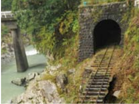
▲五味隧道。トンネルの先には馬路の村が広がる。トンネル入口の土を除去して線路を敷設した
