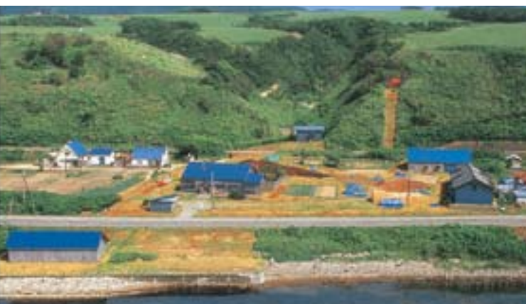
◀佐賀家の漁場。手前左が廊下、道路上中央が番屋、右手がトタン蔵、奥に船蔵、網蔵がある(留萌市提供)
