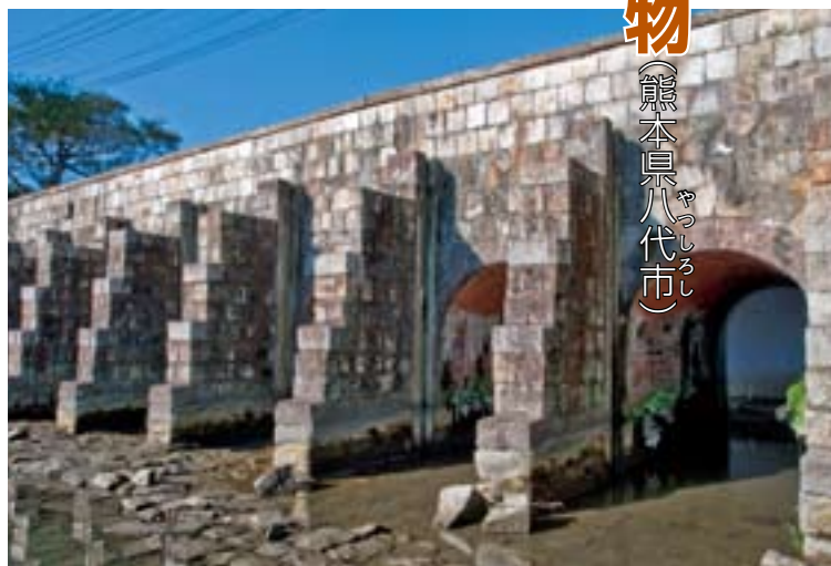
▶旧郡築新地甲号樋門。石を幾何学的に組んだ明治時代を代表する建造物として注目される
