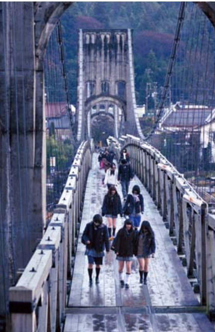
▲木曾川上に端麗な姿を見せる桃介橋。中州にコンクリートの支柱をたてワイヤーロープを張って吊っている ▼桃介橋を渡って通学する高校生たち
