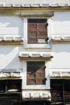
▲6段の水切り瓦が敷かれる藤村製糸の繭蔵。明治32年に酒蔵として建築された建物
