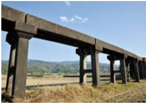
▲立岡二号棧道。昭和8年建造の石積高架。農業用道路や田畑を避けるため造られたもので、緩やかなカーブ曲線
