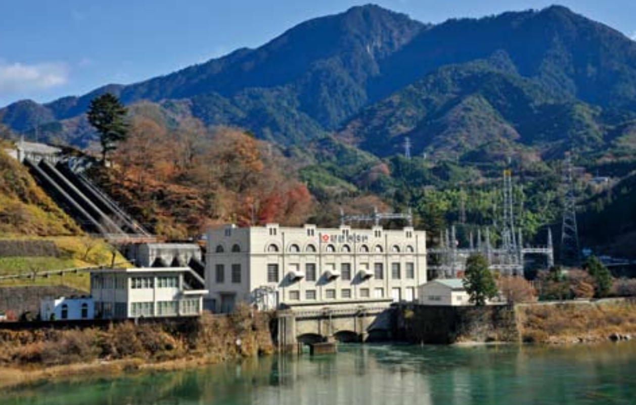
▲木曾川のほとりに建つ読書発電所。鉄筋コンクリート造りのレンガ壁、半円形の飾り窓を配した優雅な雰囲気をもつ
