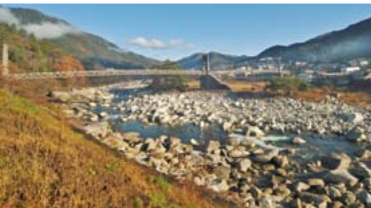
▲木曾川上に端麗な姿を見せる桃介橋。中州にコンクリートの支柱をたてワイヤーロープを張って吊っている ▼桃介橋を渡って通学する高校生たち
