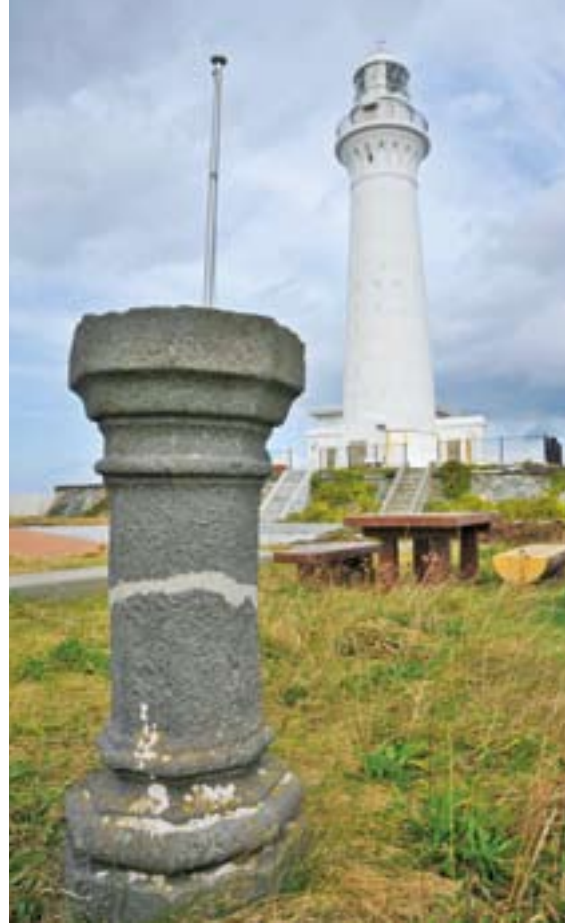
▲レンガ造りでは日本最高の高さを持つ尻屋埼灯台
