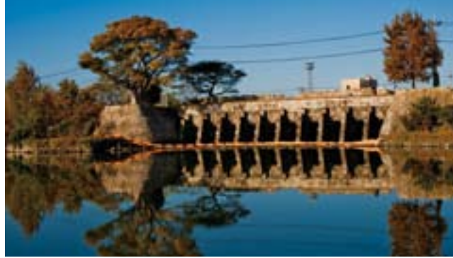
▲旧郡築新地甲号樋門俯瞰。黄色いオイルフェンスが張られている
