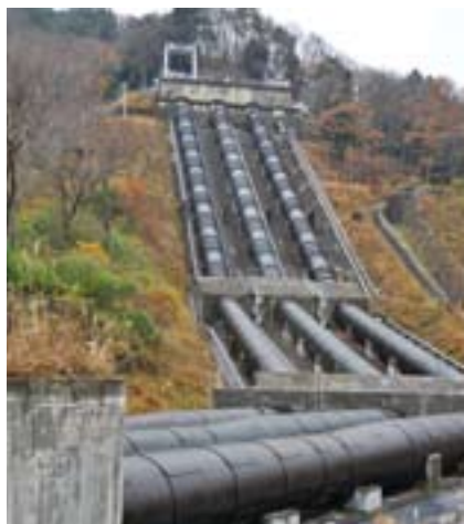
▲操業当時のまま、現在も使用されている水槽と水圧鉄管。落差112m。水槽には正面、側面部分に建設当時のデザインが残されている
