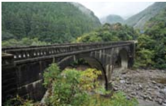
▲二股橋。昭和15年建造の無筋コンクリート2連アーチ橋。全長46.9m、幅3.5m、堀ヶ生橋と同規模。橋と川との景観美が人気
