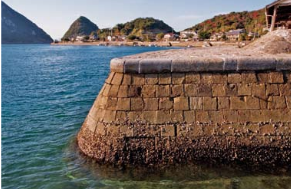
▲三角西港埠頭、東側排水路の出口で
