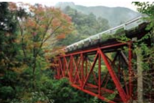
▲犬吠橋。馬路～魚梁瀬間開通当時は木造だったが、大正13年に鋼トラス橋に架け替えた。谷底から足場を組む写真も残っている
