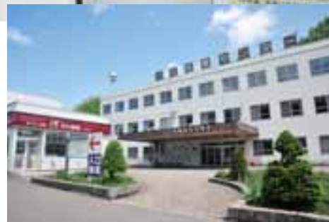
▲夕張希望の杜、医療センター建物
